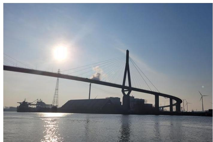
Die Durchfahrtshöhe für Schiffe beträgt 51 m bei mittlerem Hochwasserstand. Großcontainerschiffe wie die Alexander von Humboldt mit knapp 400 m Länge können wegen ihrer Höhe über Kiel (in diesem Fall sind das 69,5 m) am Containerterminal Altenwerder nicht anlegen, weil sie auch bei niedrigstem Wasserstand nicht unter der Brücke durchpassen.
